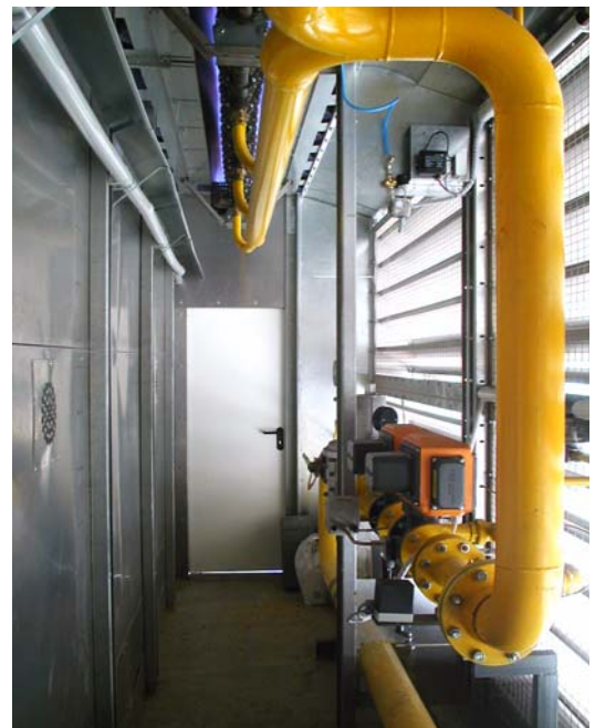
Chauffage d'air en direct avec des brûleurs NP- III AIRFLO® dans des sècheurs à flux continu pour le grain.
